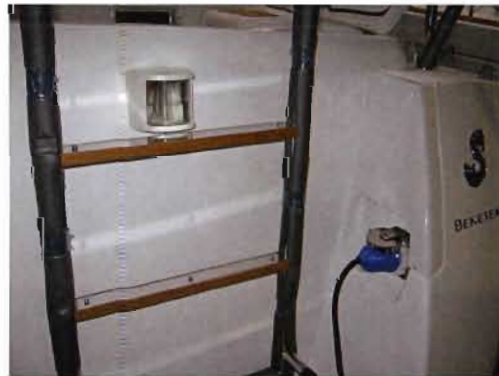
Shore power socket 220V - 30A (Landmark 1)
